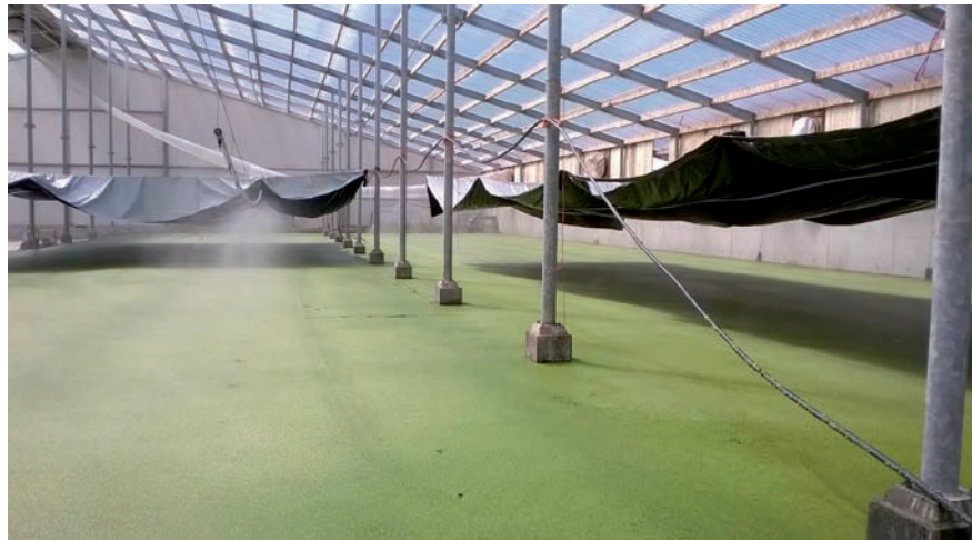
Figuur 11: Schaduwzeil en verneveling in warme zomermaanden.
