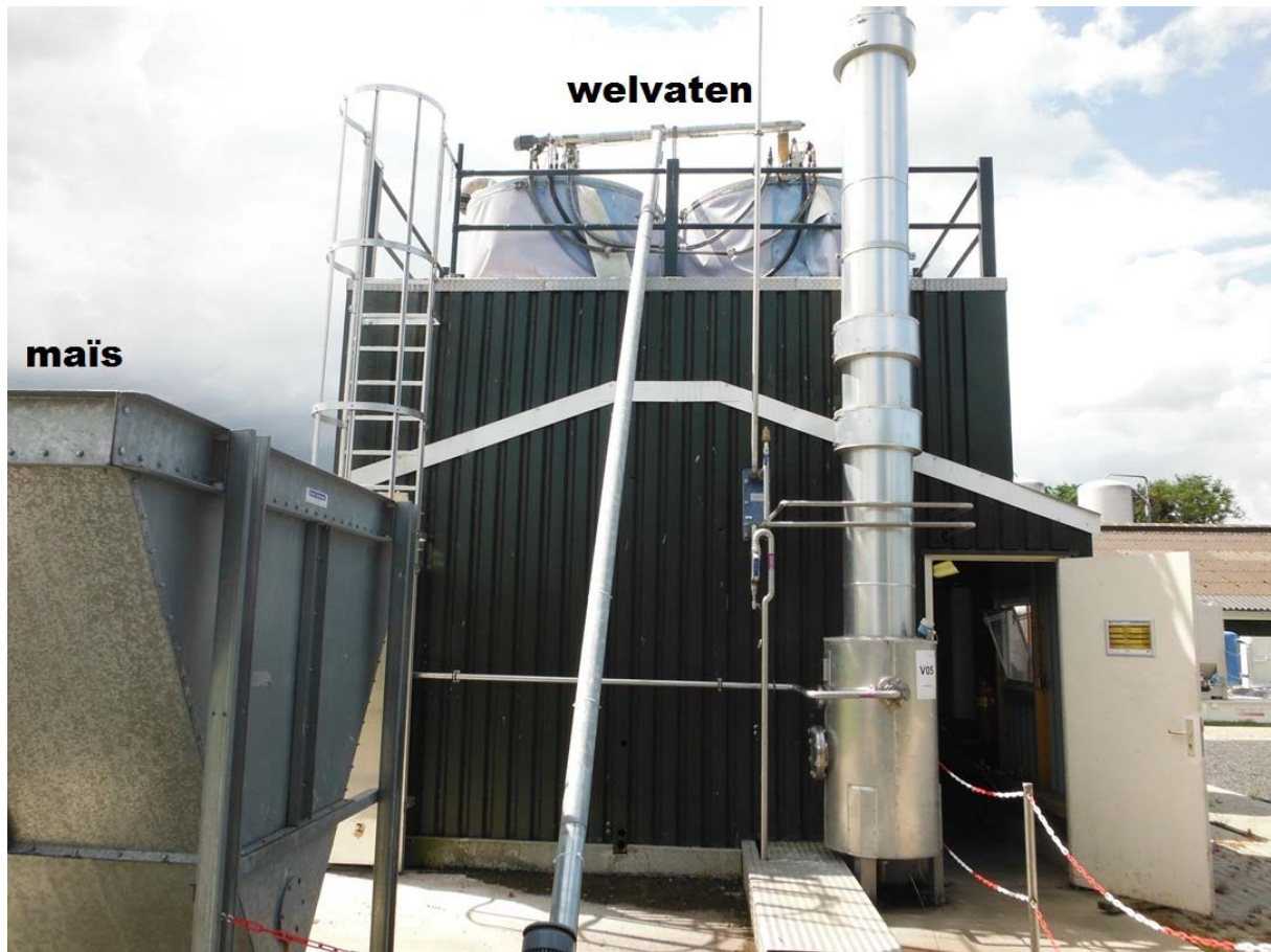
Foto 1: Maïskorrels worden omhoog getransporteerd naar de welvaten
